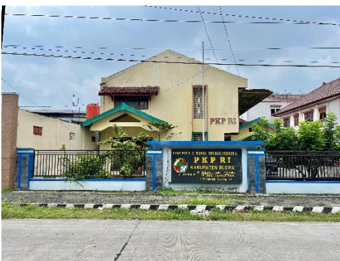
Gedung PKPRI Tampak Depan
