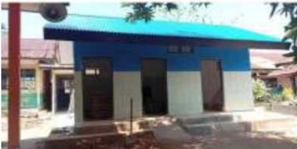
Foto: Pembangunan toilet di SMPN 1 Bungoro, Pangkep, Sulsel. (Dok. Istimewa)
